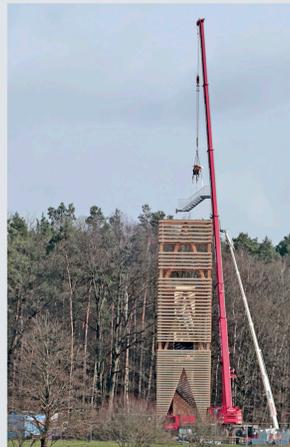
Foto 8: Die ersten Treppenabschnitte werden von oben in den Turm hereingehoben (11.3.2024)
