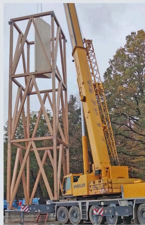
Foto 5: Einheben des ersten Teilstückes des dreieckigen Innenkerns (9.11.2023)
