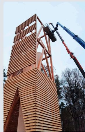
Foto 6: Anbringen der Fassadenverkleidung (1.12.2023)
