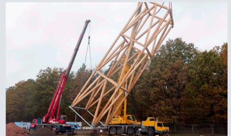
Foto 4: Aufrichten der fertigen Fachwerkstragkonstruktion (9.11.2023)
