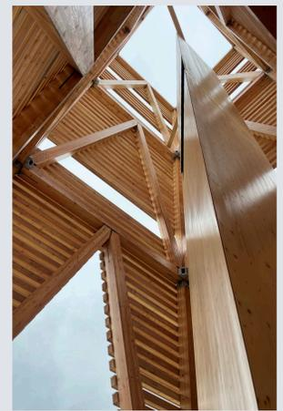
Foto 7: Der „leere“ Turm von innen: Fassadenverkleidung und der Kern (bis auf das oberste Teilstück) sind fertig (6.2.2024)
